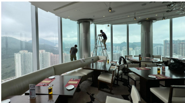
安裝 i-Film 工程中 Installation of i-Film
