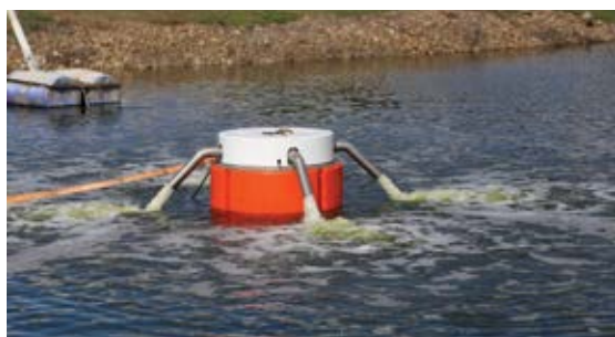
高能源效益的微氣泡A-JET技術為DMBR系統曝氣
