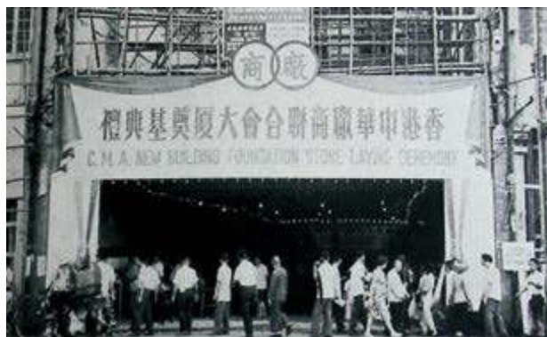
1962 年廠商會大廈第一次擴建的奠基儀式。
